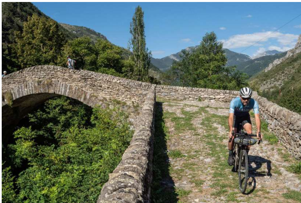
Pont du Coq, La Brigue
